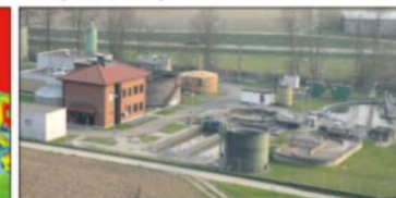
Auf dem Klärwerk am Eichersheimer Ortsteil soll eine Solaranlage installiert werden. Die zahlreichen Pumpen können damit versorgt werden. Foto: März
